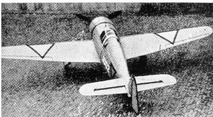
Le prototype et un ou deux appareils commandés par la Hollande portaient un moteur Mercury, dont le capot était plus carré et plus ouvert que celui du modèle français.
