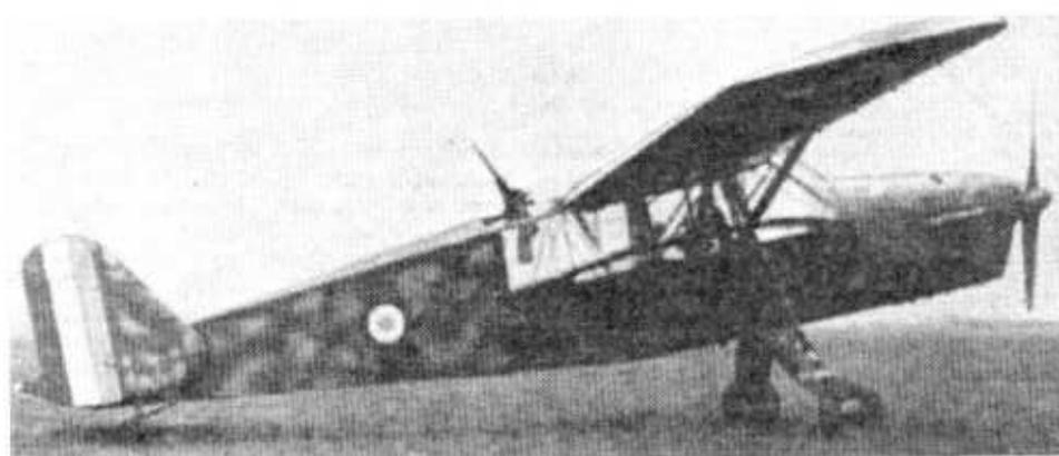
Cette très mauvaise photo semble être la seule connue du SFAN 11, de même les dimensions exactes ne sont pas connues. Moteur Renault 220 ch
