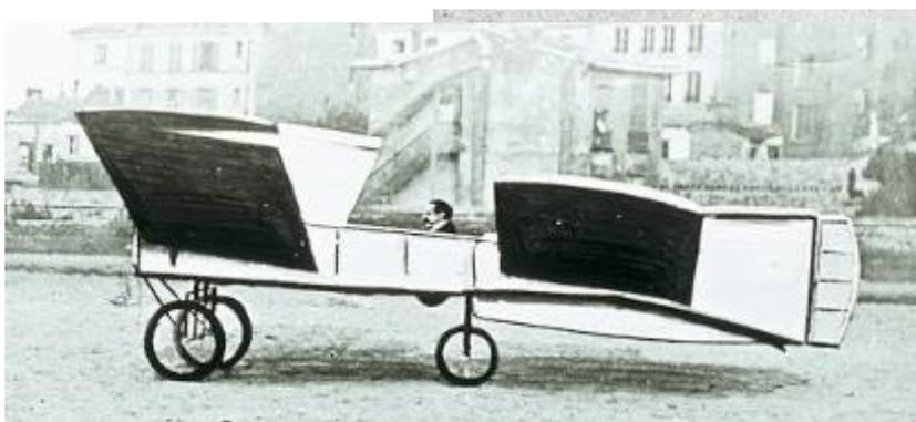
**Version 2** Modifiée en quelques jours. Aile avant reculée de près de 1 m, prolongateur d'hélice supprimé et radiateur passant du dessous du fuselage (comme sur le canard V) à l'avant avec accessoires à l'arrière, les tuyaux passant de part et d'autre du siège coulissant sous le fuselage. Plusieurs bonnes photos en atelier sont disponibles permettant de préciser des détails valables pour les versions suivantes. Une photo plein arrière permet de distinguer des accessoires
